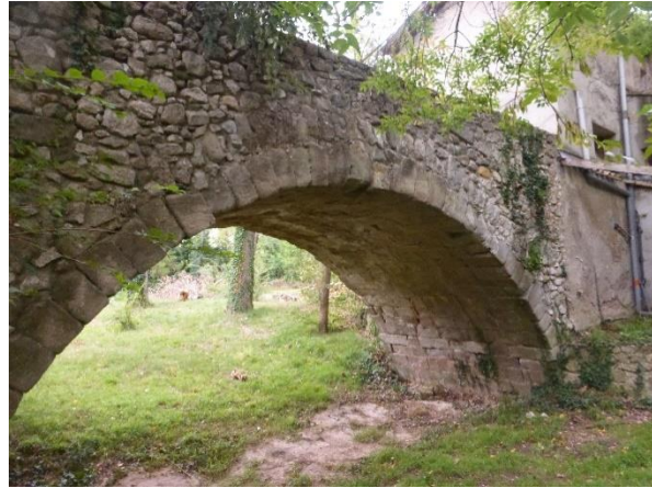
Ancien pont de Bachasson (Photo : M. Faure / Naturalia)
