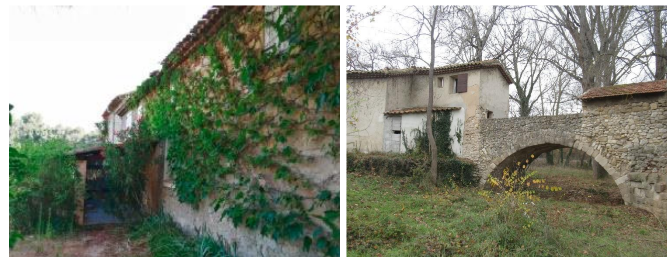
Figure 100. Illustrations des bâtis B2 et B5 épargnés au titre de la ME4, avant destruction partielle. Photos : Naturalia
