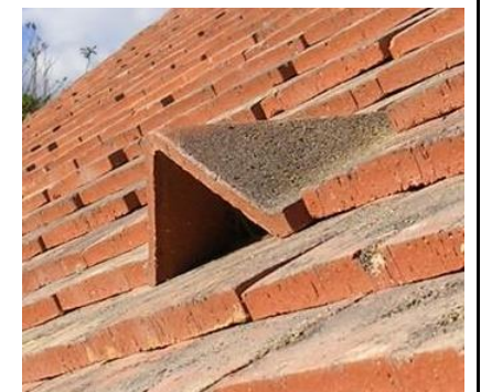
Figure 120. Tuile chatière permettant l'accès au sous-toit
